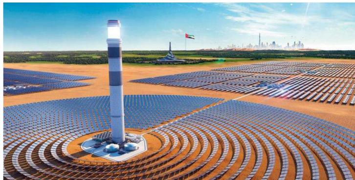
Gambar 2.3 Pembangkit dengan Sistem Menara Tenaga Surya
