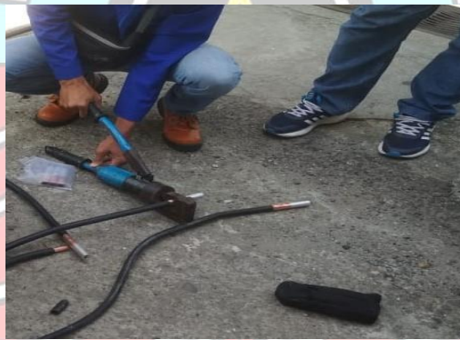
Pemasangan skun kabel
