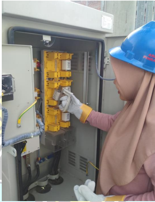
Pemasangan atau pelepasan NH fuse
