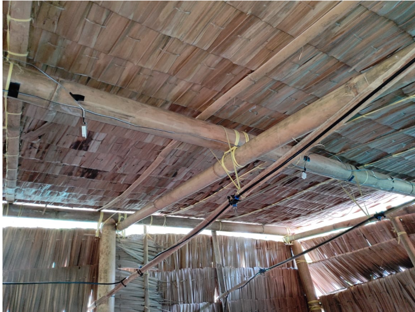
Gambar 4.1 Nozzle-nozzle yang terpasang pada langit-langit dalam kumbung jamur.
