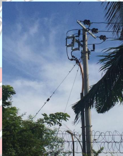
Gambar 2.10 Tiang Penegang / Tiang Tarik di jalan Metro Tanjung Bunga
