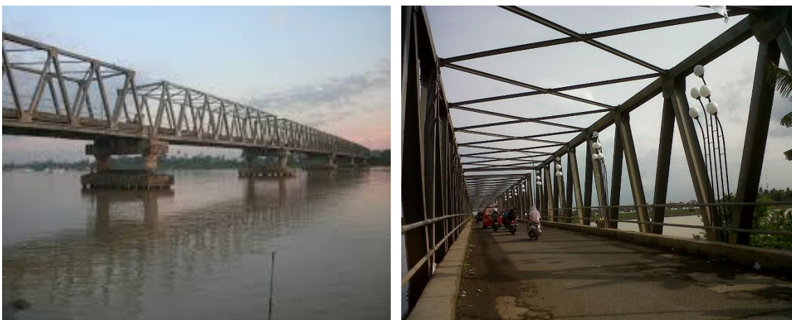
Gambar 2.4. Lokasi Implementasi perangkat SHMS (Jembatan Barombong di Makassar)
