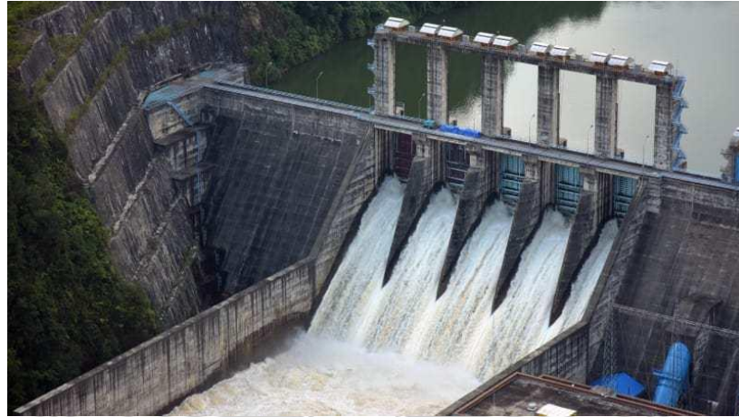
Gambar 2.4 Pembangkit Listrik Tenaga Air (PLTA) Bakaru
