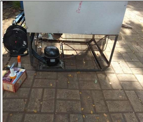
Pemasangan dan dudukan kompresor
