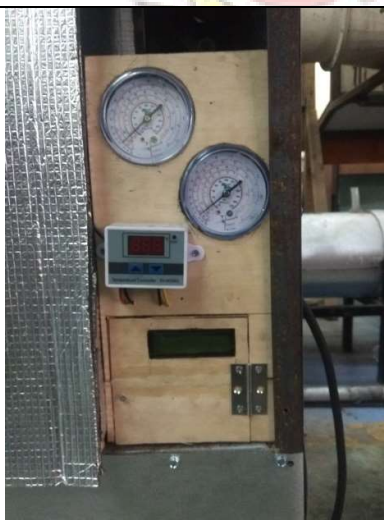
Pemasangan panel kontrol
