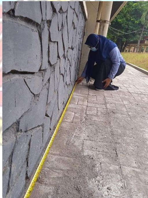
Gambar 19 Pengukuran luas dinding di setiap orientasi.
