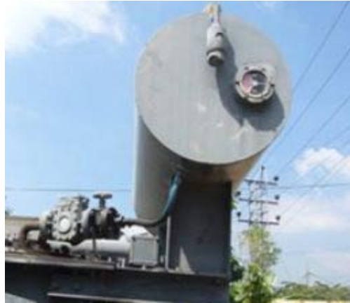
Gambar 2.4 Konservator (Sumber: Transformator Tenaga, PT PLN)
