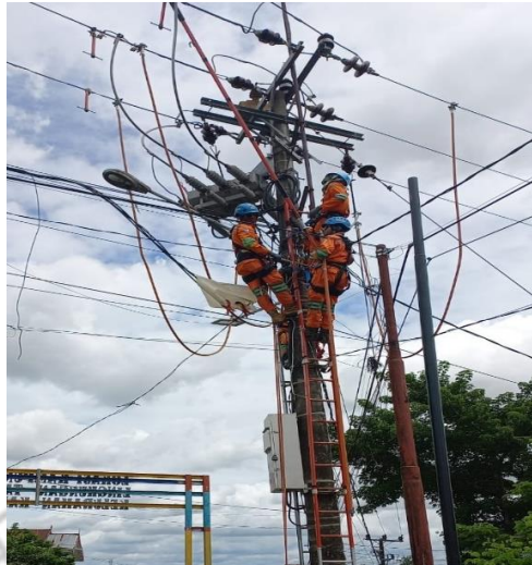
Gambar 2.18 PDKB-TM Metode Berjarak (Sumber : Dokumentasi Pribadi, 2021)
