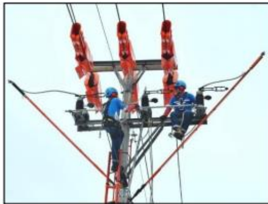
Gambar 2.15 PDKB Tegangan Menengah (Sumber: Julia Sandi, 2017)
