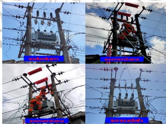
Gambar 4.2 Pengerjaan PDKB-TM UP3 Parepare
