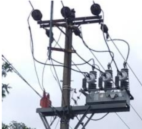
Gambar 2.13 Recloser / Pemutus Balik Otomatis (Sumber: PT. PLN (Persero) ULP Mattirotasi, 2021)
