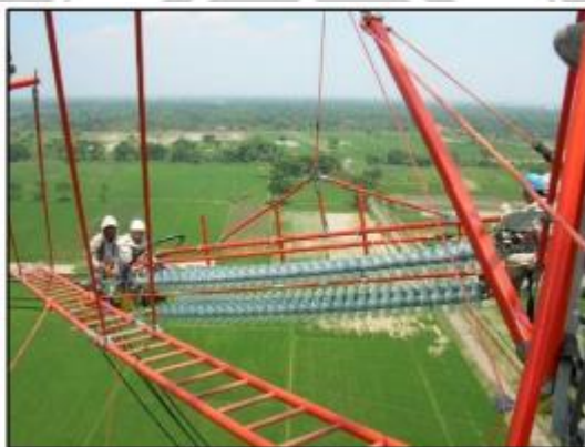
Gambar 2.16 PDKB Tegangan Tinggi (Sumber: Julia Sandi, 2017)
