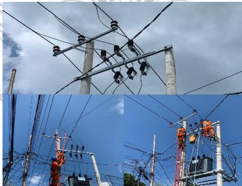
Gambar 4.4 Pengerjaan PDKB-TM UP3 Parepare
