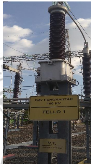
Gambar 4 Trafo Tegangan
