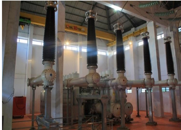
Gambar 28 Peralatan GIS 150 KV Bontoala
