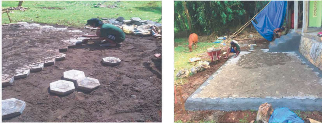
Gambar 3. Pengerjaan teras mushallah dengan menggunakan paving block
