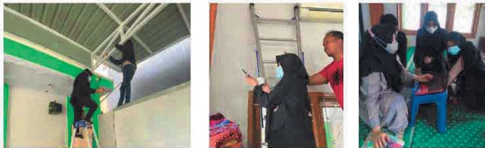
Gambar 7. Pemasangan kamera CCTV pada titik target dan proses instalasi aktivasi di wilayah masjid Raudhatul Jannah.
