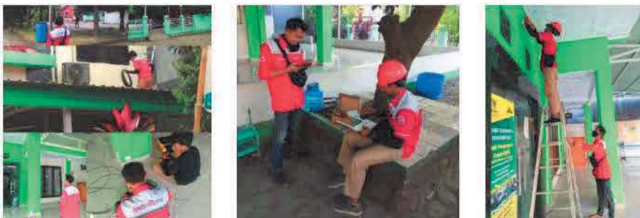
Gambar 6. Mitra Industri melaksanakan pemasangan Kabel Indihome ke target lokasi Mitra PKM.
