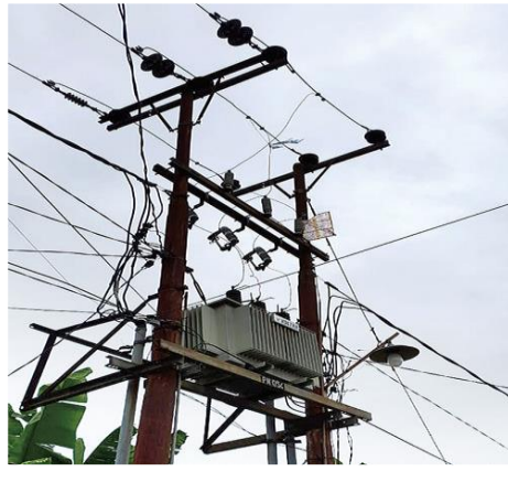
Gambar 4,10 Rangka layang layang yang menggantung di kawat FCO di jalan poros bira
