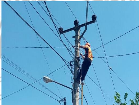
Gambar 4.2 kegiatan pembenahan travers miring
