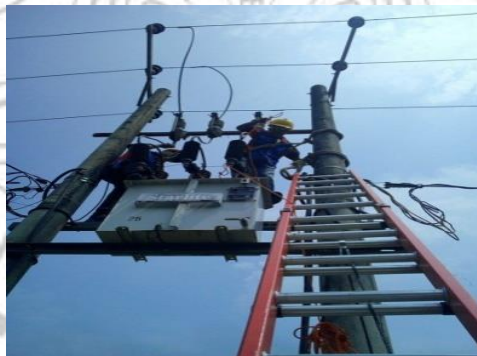
Gambar 4.4 proses penggantian FCO
