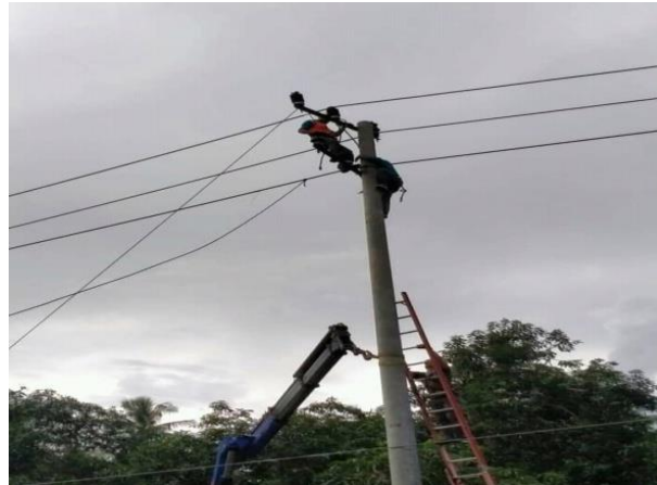
Gambar 4.3 proses pembenahan travers yang miring
