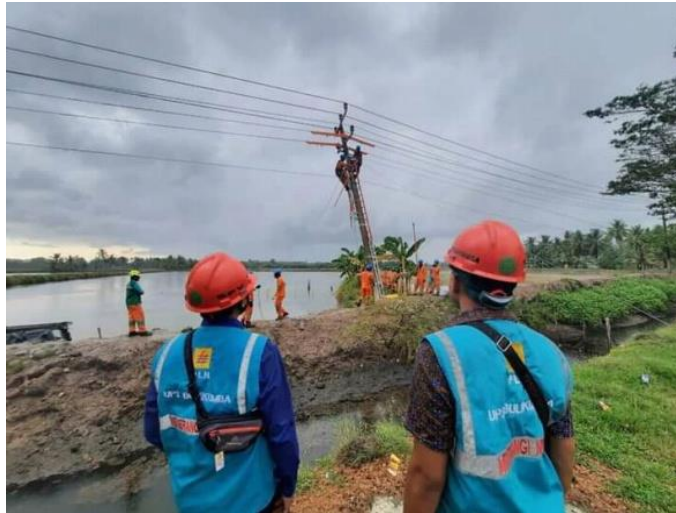
Gambar 4.8 kegiatan pembenahan tiang miring di dusun tarampang
