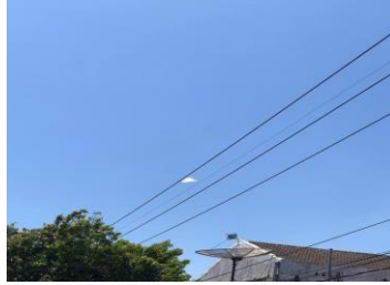
Gambar 2.10 Kerangka Layang-layang Pada Jaringan SUTM (Gonen,2013)
