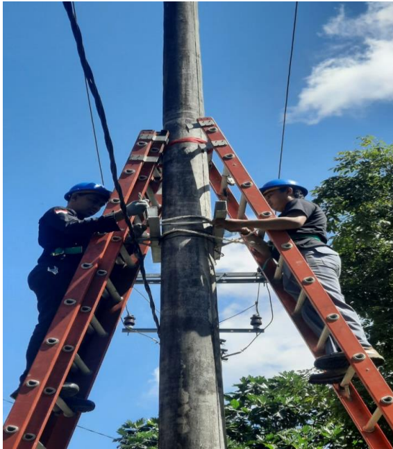
Lampiran 1. Pemasangan Dudukan Trafo
