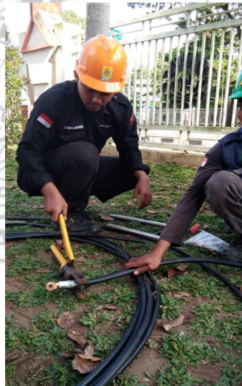
Lampiran 7. Pemasangan Skun pada Konduktor AAAC-S
