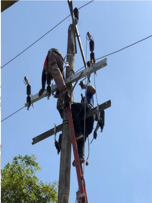
Lampiran 5. Pemasangan Fuse Cut Out dan Lightning Arrester
