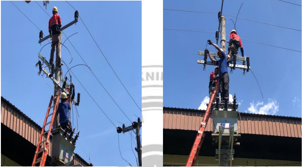
Lampiran 9. Hasil Pemasangan Gardu Distribusi Tipe Cantol
