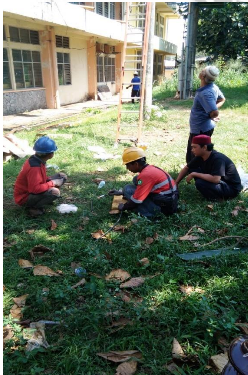
Lampiran 7. Pemasangan Skun pada Konduktor AAAC-S
