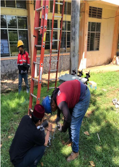
Lampiran 4. Perakitan Fuse Cut Out dan Lightning Arrester
