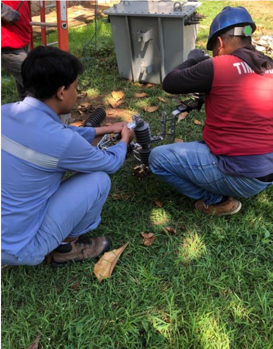
Lampiran 4. Perakitan Fuse Cut Out dan Lightning Arrester
