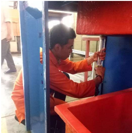
Pemasangan flowmeter
