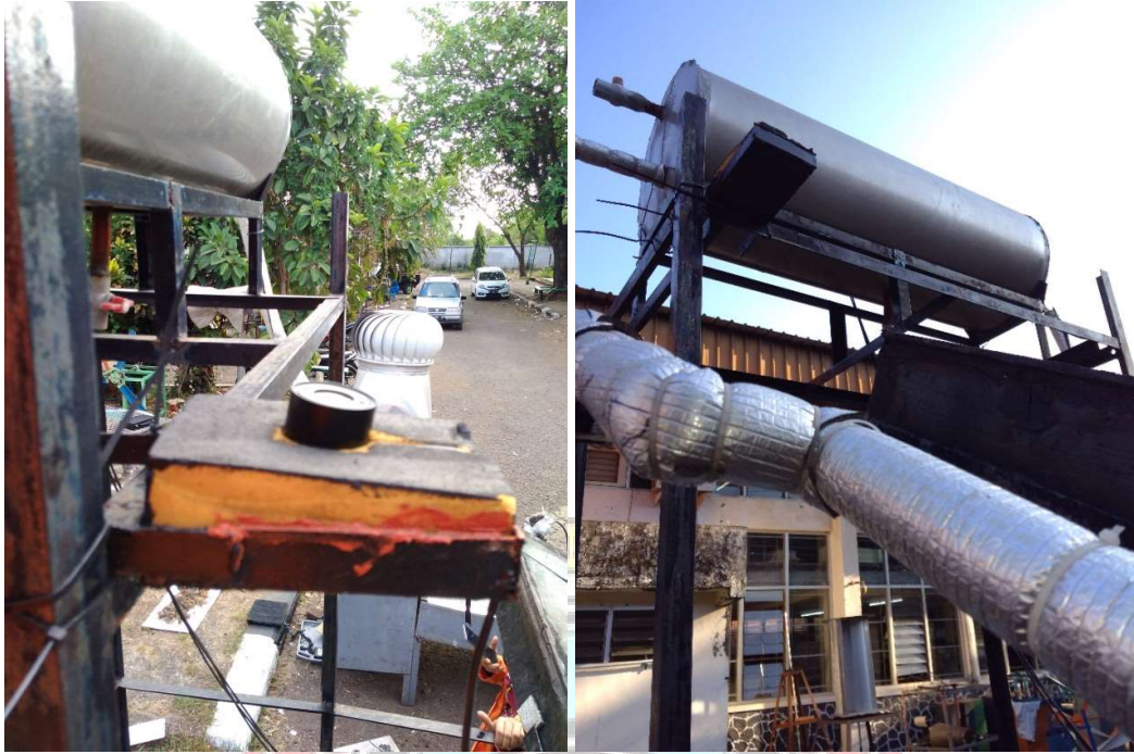
Proses pemasangan alat ukur dengan posisi sudut konstan 5^\circ .
