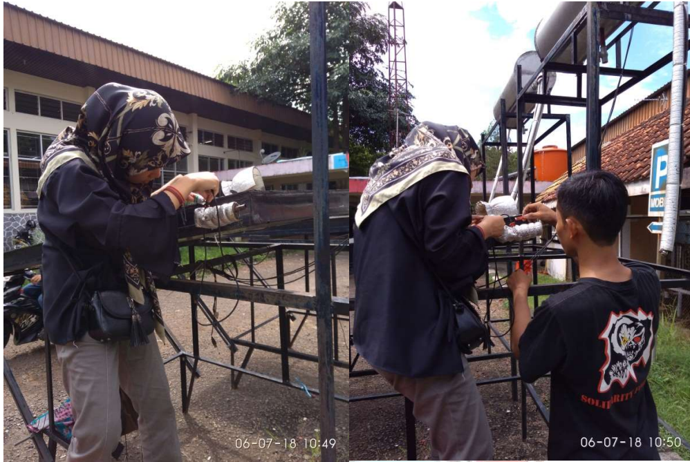
Proses penggantian sensor yang rusak
