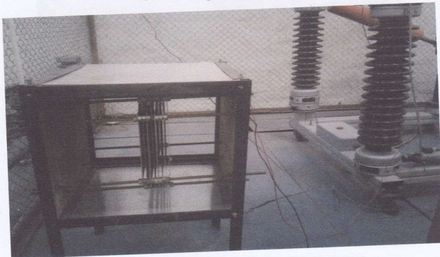
Proses pemasangan tegangan tinggi DC ke filter
