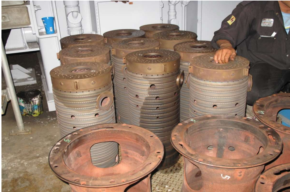
Gambar 2.4 Komponen dalam Ruang bakar pada turbin gas PT. PLN Tello
