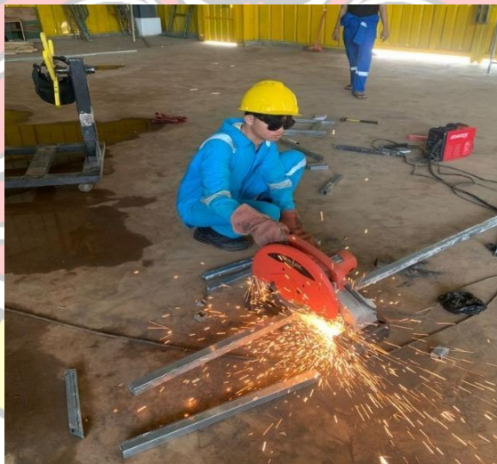
Gambar 3. 5 Pemotongan Komponen Rangka
