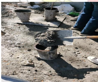
Gambar 12.4 Oleskan oli pada mal kemudian masukkan campuran beton kedalam mal
