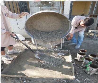
Gambar 12.3 Mencampur material beton didalam mesin
