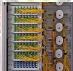
Gambar 2. 7 Optical Distribution Cabinet (ODC)
