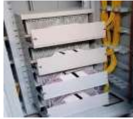
Gambar 2. 6 Optical Distribution Frame (ODF)
