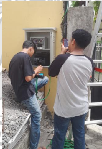
Gambar 3.8 Pemasangan sumber PLTS ke SCC
