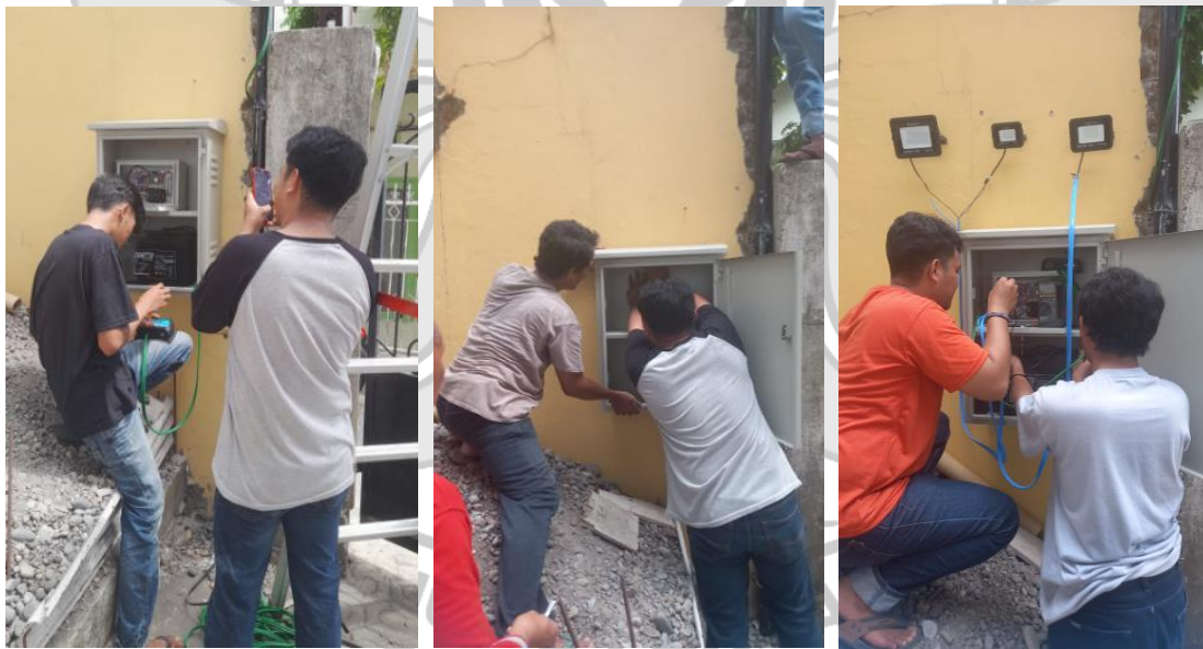
Proses pemasangan alat
