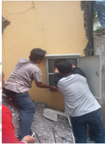
Gambar 3.7 Pemasangan panel box
