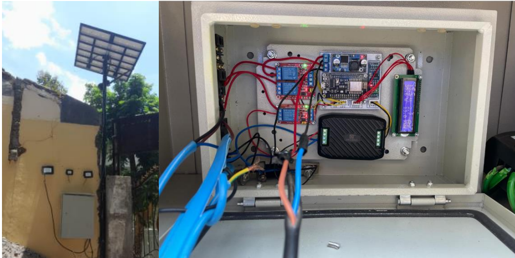
Hasil pembuatan dan pemasangan alat
