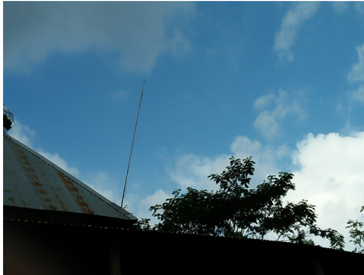
Gambar 4. Hasil pemasangan instalasi penyalur petir
