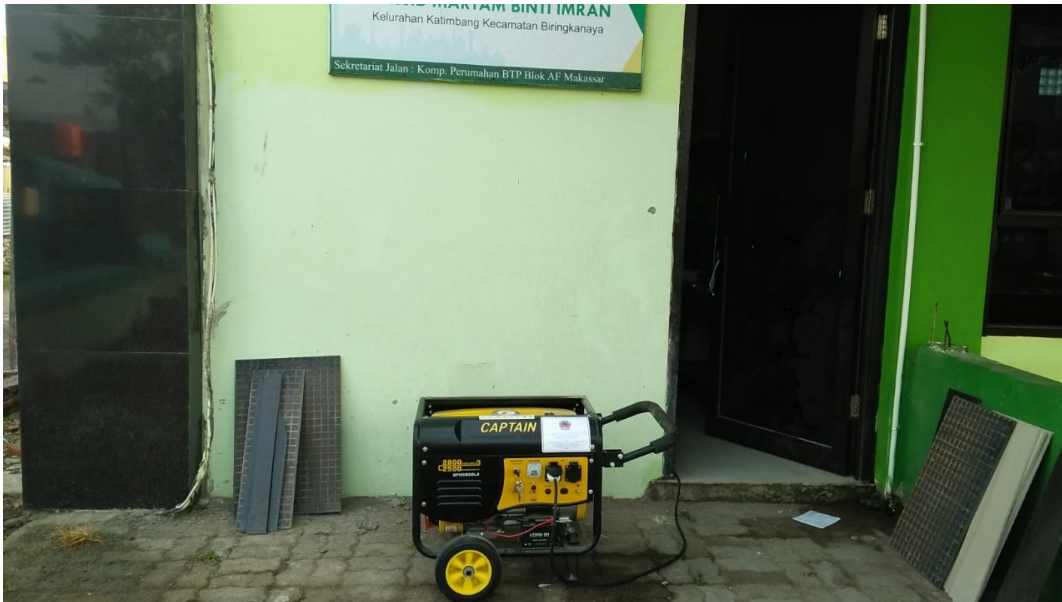
Gambar 3. Peralatan generator-set sebagai CDP
