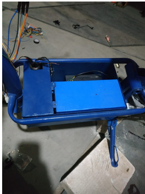
b) Penempatan baterai ke box baterai
