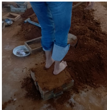
Gambar 3. 26 Proses Pematatan Tanah
