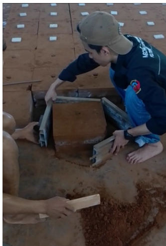
Gambar 3. 32 Melepaskan Rangka Cetakan
