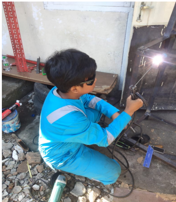
Gambar L6 Proses Penyambungan Besi Menggunakan Las Listrik
