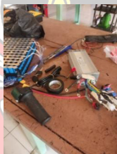
Gambar 4.9 Perakitan Sistem Kelistrikan
