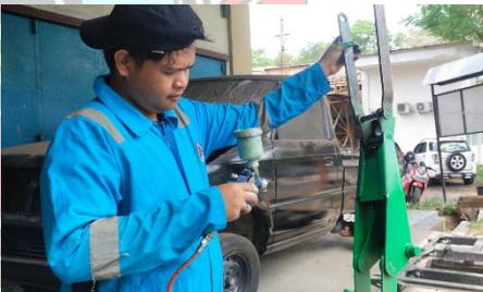
Pengecatan dongkrak hidrolis B
