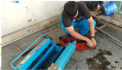
Gambar 4. 3 Pembongkaran dongkrak hidrolik A
