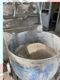
Mencampur Material Menggunakan Mesin Pengaduk
