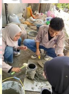
Memasukkan Campuran pada Cetakan
