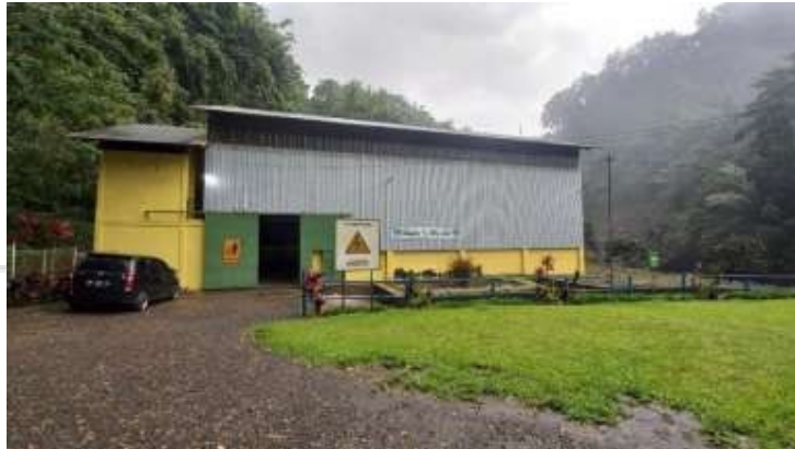
Gambar 5.12 Dokumentasi PLTMHPT.Tombolo Energi
