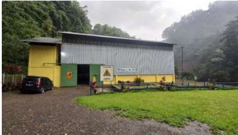
Gambar 5.16 Dokumentasi PLTMH PT.Tombolo Energi
