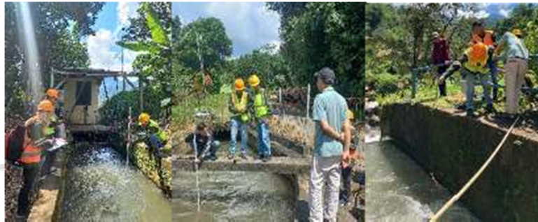
Gambar 5.15 Pengukuran Saluran Waterway , Saluran Masuk Headpond , Tailrace Menggunakan Current Meter & Rambu Ukur
