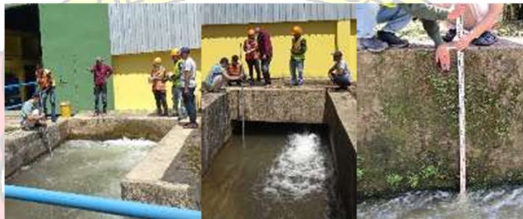
Gambar 5.20 Pengukuran Tailrace Turbin 2,5 MW Dan 0.5 MW Menggunakan Current Meter & Rambu Ukur
