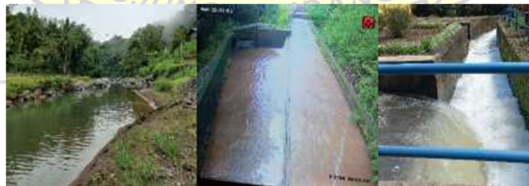
Gambar 5.18 Reservoir Alami, Saluran Waterway , Saluran Pelimpah Dan Saluran Tailrace PLTMH PT.Tombolo Energi
