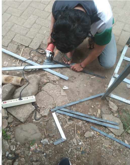
Gambar 3. Pemotongan Besi
