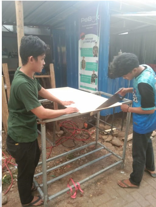
Gambar 5. Pembuatan Alas Bak Penampung Air
