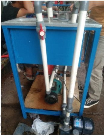
Gambar 12. Intalasi Pipa Air
