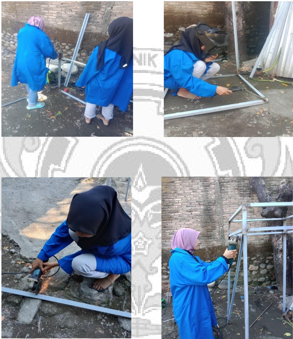
Gambar 1. Proses Pembuatan Rangka
