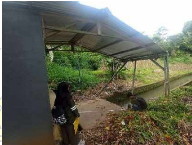
Mengukur luas bangunan trash rack
