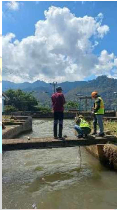
pengukuran kecepatan air pada water way (sebelum headpond)
