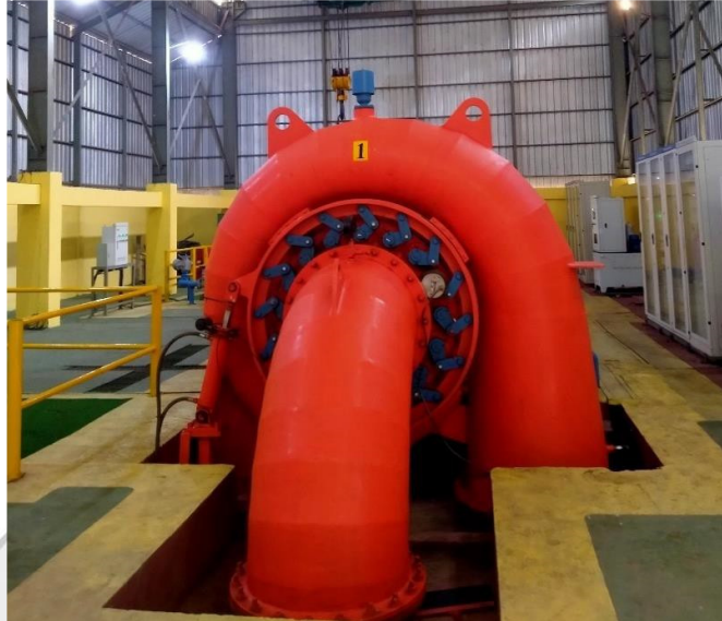
Gambar 2.3 Turbin PLT Minihidro Tombolo Energi
