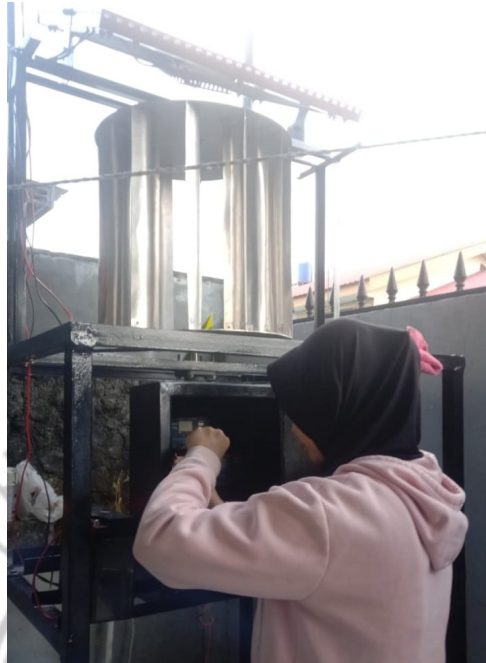
Proses perakitan rangkaian listrik
