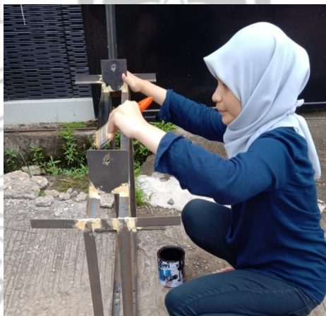
Proses pengecatan dan pendempulan kerangka PLTH
