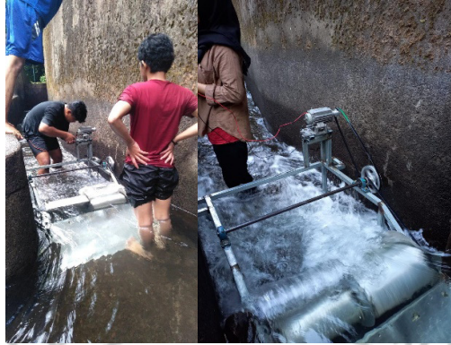
Proses penempatan turbin
