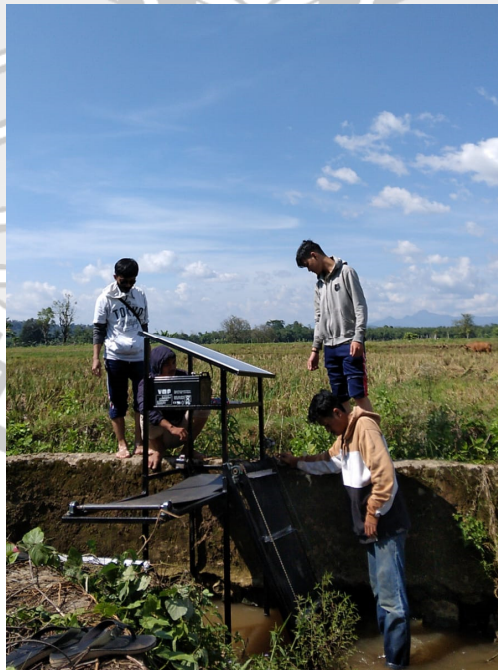
Peletakkan Mesin Trash Trap pada Saluran Air
