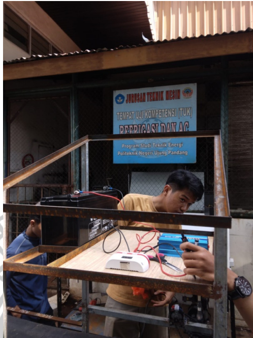
Penyambungan Instalasi Sumber energi
