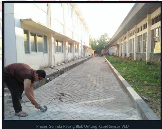
Pengerjaan Gerinda Paving Blok Untung Kabel VLD
