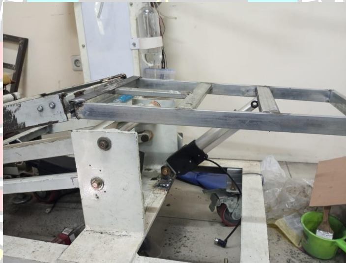
Pemasangan electric actuator linear
