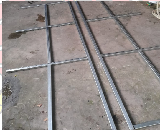
Gambar 4. 1 Pemotongan Rangka Besi
