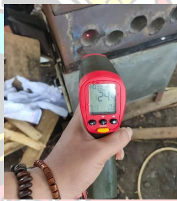
Suhu ruang pipa pembakaran
