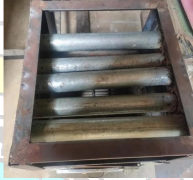
Proses pemasangan pipa galvanis
