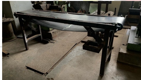
Pemasangan belt pada rangka konveyor
