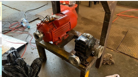
Pemasangan dinamo motor dan gearbox
