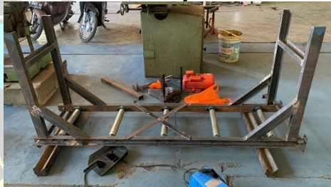
Perakitan rangka sekaligus pemasangan roller konveyor
