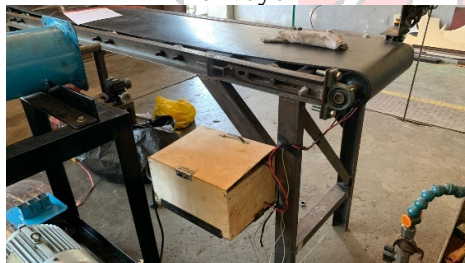
Pemasangan box elektronik
