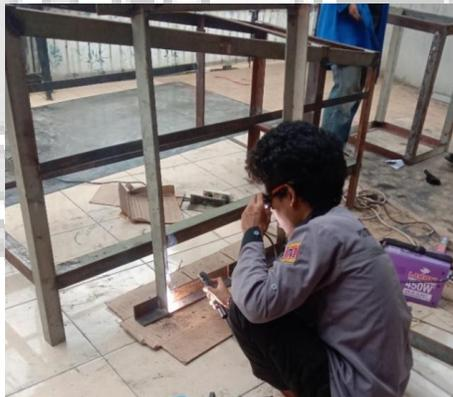
(Proses Pengelasan Rangka Mesin)
