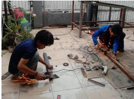
(Proses Pemotongan Besi Siku)
