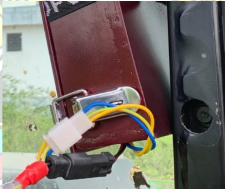
Gambar 3.13 pemasangan soket pada box
