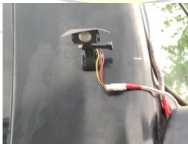
Gambar 3.11 peletakan sensor pada pintu batrei
