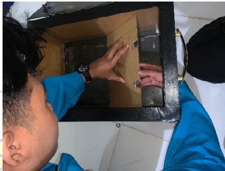
Gambar 21 Pemasangan kaca akrilik
