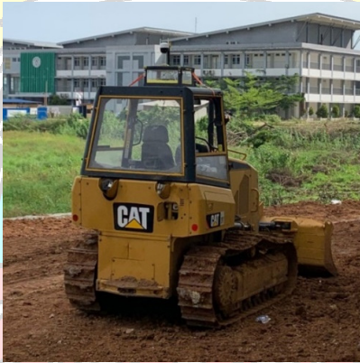
Gambar 43 Posisi pemasangan kamera 360 portable pada dozer
