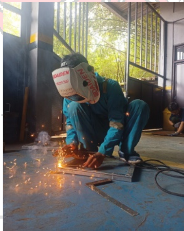
Gambar 3.5 Pengelasan rangka
