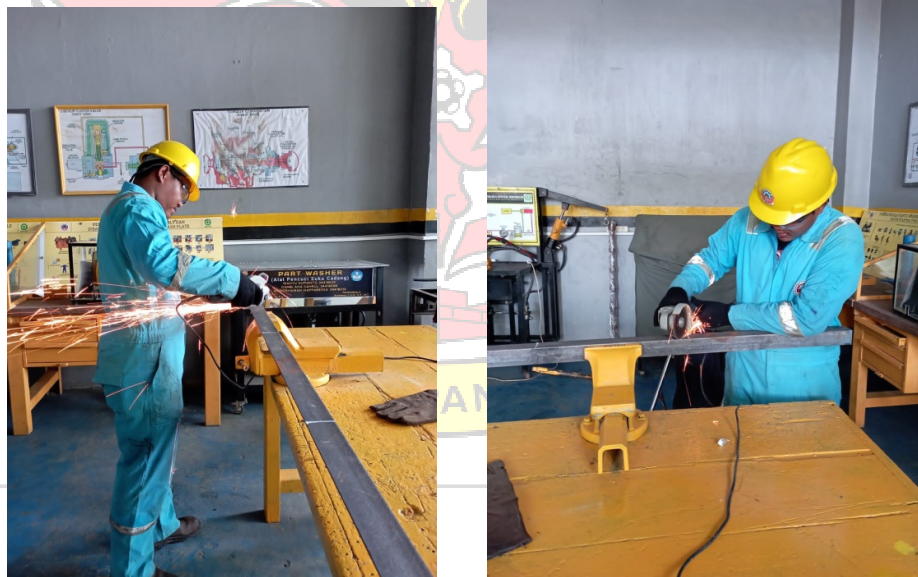
Gambar 4.6 Pemotongan Besi Siku
