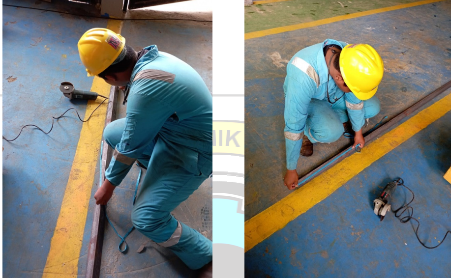
Gambar 4.5 Proses Pengukuran Rangka Besi
