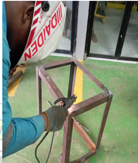
Gambar 4.7 Pengelasan Besi Siku
