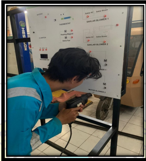
Gambar 4.9 Pemasangan komponen kelistrikan
